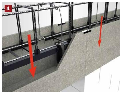
Der Bewehrungskorb wird in die Ringbalken- und Sturzschalung eingelassen. Bei Verwendung des Bewehrungskorpositionierers ist eine ausreichende Betondeckung gewährleistet.
