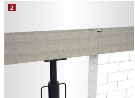
Die Schalung wird mit der entsprechenden Anzahl an Stützen abgestützt.
