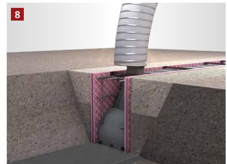
Gegebenenfalls muss die Schalung beim Betonieren weiter mit Erdreich angefüllt werden.
