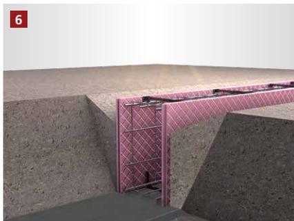
Die oberen Easy Klick Distanzstücke werden eingesetzt. Die Schalung wird zu mindestens 2/3 mit Erdreich angefüllt.
