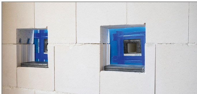
Abb. 39: Podest auf Höhe der Wandaussparungen positionieren
