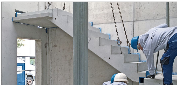
Abb. 54: Treppenlauf positionieren
