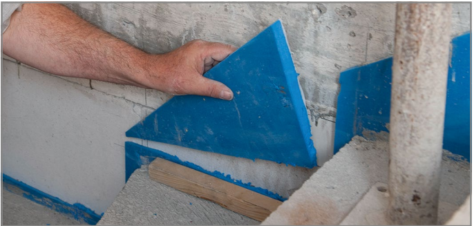
Abb. 132: Tronsole® Typ L mit Überstand abschneiden
