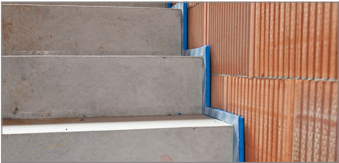
Abb. 145: Überstand der Fugenplatte kontrollieren
