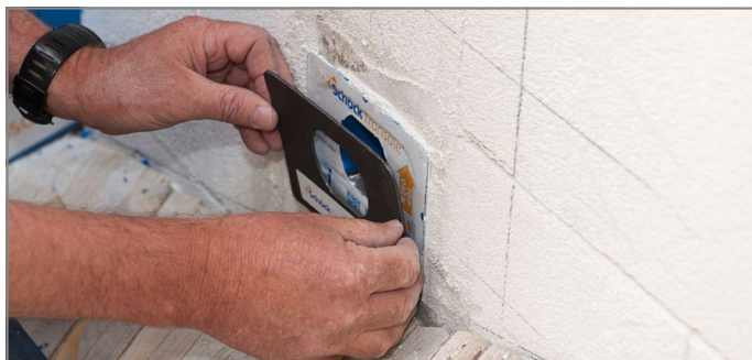
Abb. 61: Brandschutzabdeckung aufkleben
