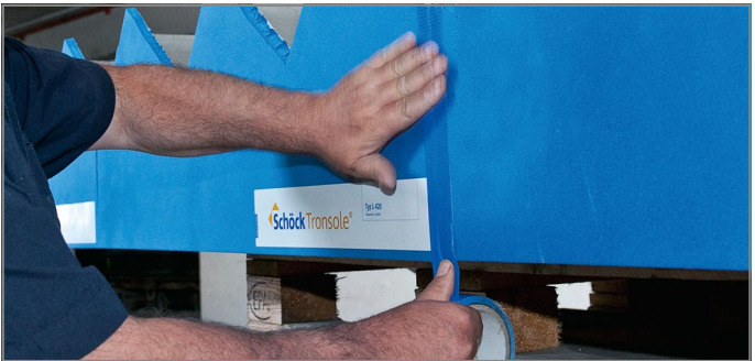
Abb. 142: Stöße von Tronsole® Typ L verkleben
