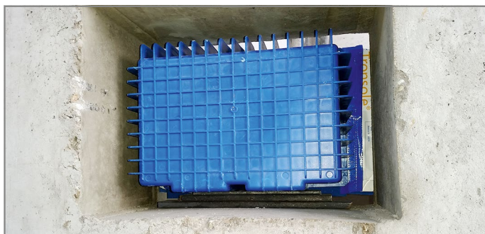
Abb. 55: Höheneinstellung Tronsole® Typ Z vollflächig und kraftschlüssig mit druckfesten Unterlegplatten vornehmen
