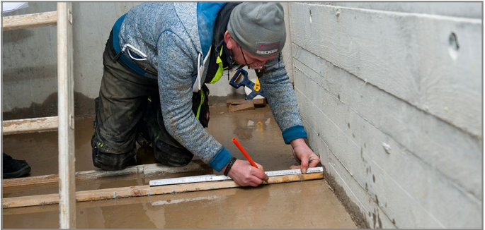
Abb. 113: Position der Tronsole® Typ D auf der Bodenplatte einzeichnen
