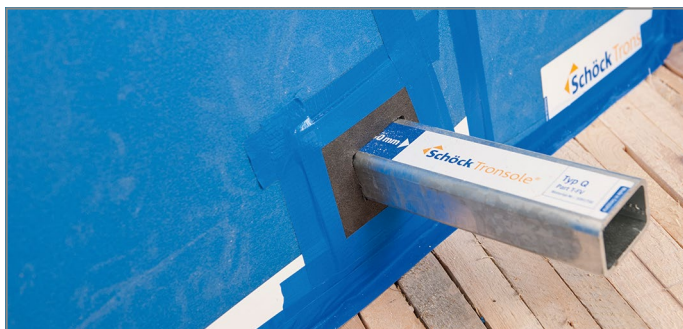
Abb. 67: Tragelement montieren und Brandschutzmanschette abkleben
