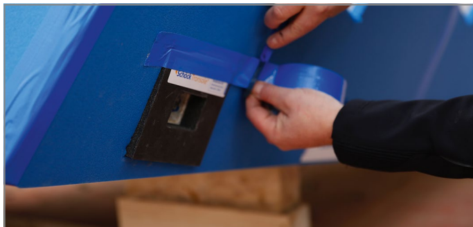
Abb. 76: Brandschutzmanschette einsetzen und abkleben
