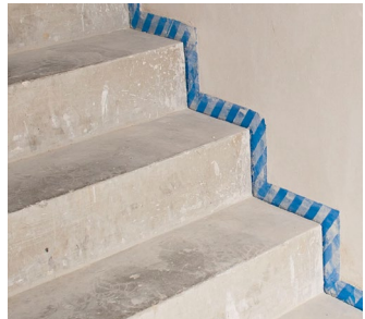
Abb. 5: Blaue Linie zeigt durchgängige Entkopplung
