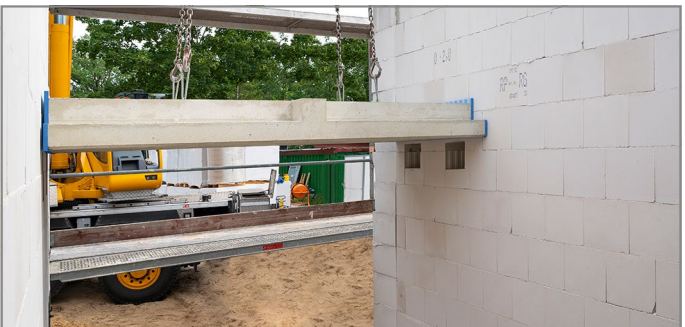
Abb. 38: Podest zwischen den Treppenhauswänden einheben
