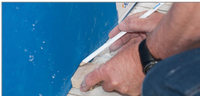
Abb. 125: Unteres Laufprofil von Tronsole® Typ L anzeichnen
