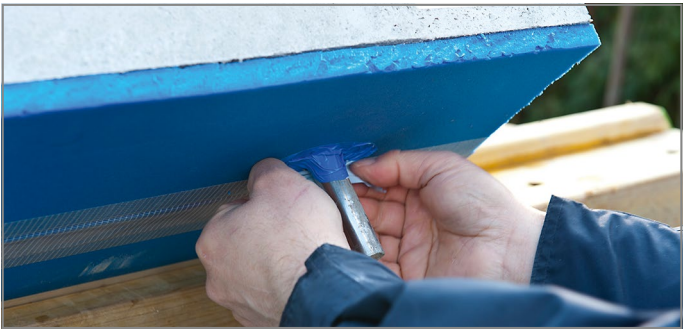
Abb. 118: Tronsole® Typ D und Typ B abkleben, sodass keine Schlämme einlaufen können
