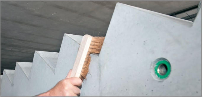
Abb. 135: Staub und lose Teile entfernen
