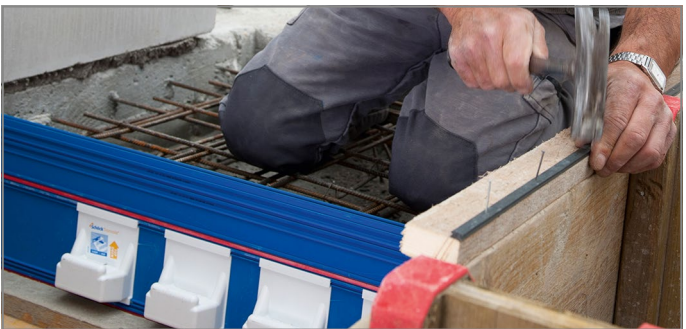
Abb. 90: Obere Nagelleiste anbringen
