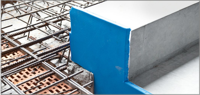
Abb. 144: Oberes Auflager der Treppe kontrollieren
