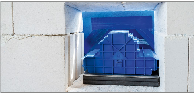
Abb. 49: Wandaussparung vergießen
