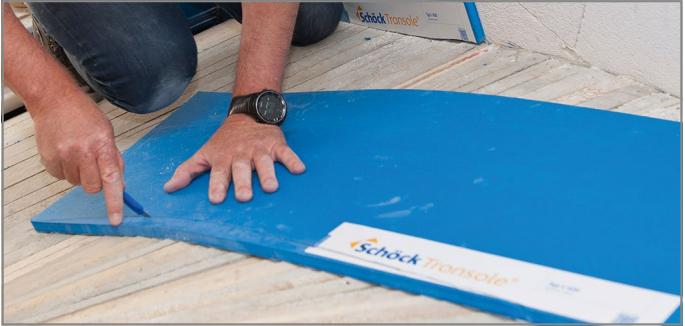
Abb. 126: Unteres Laufprofil von Tronsole® Typ L zuschneiden
