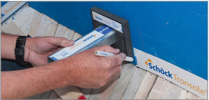
Abb. 63: Brandschutzmanschette auf Fugenplatte Typ L anzeichnen
