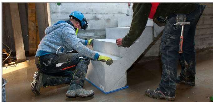
Abb. 121: Treppe absetzen
