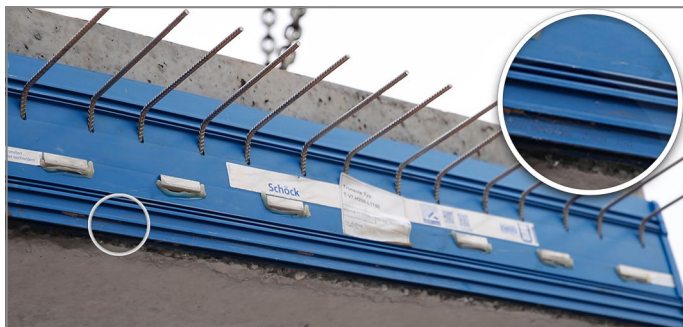
Abb. 101: Nagelleiste unbedingt entfernen
