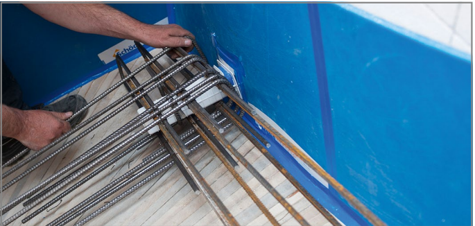
Abb. 70: Erforderliche Zusatzbewehrung verlegen
