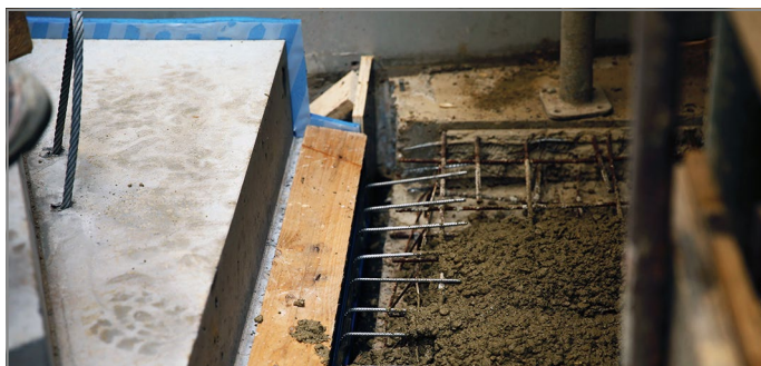
Abb. 97: Anschlussbereich betonieren
