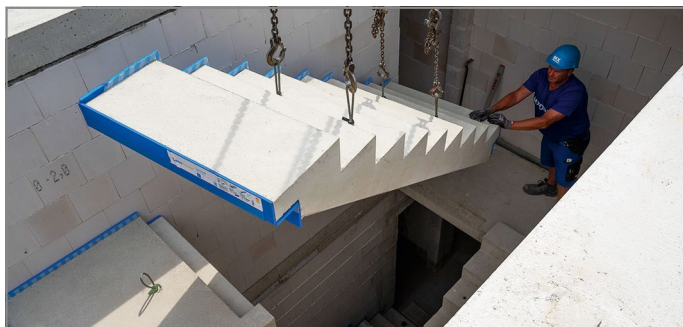
Abb. 47: Treppenlauf einheben
