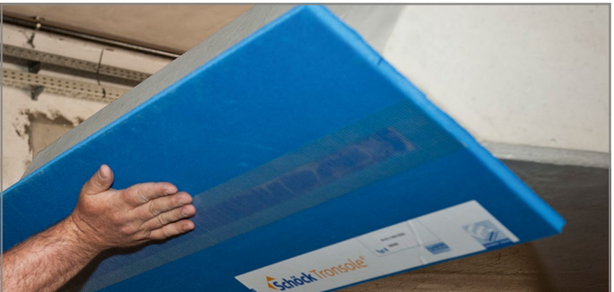
Abb. 110: Tronsole® Typ B an den Treppenfuß ankleben und andrücken, sodass die Position des Elastomerlagers Elodur® im Treppenfuß mittig liegt
