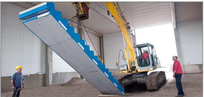
Abb. 143: Vorbereitete Treppe einsetzen
