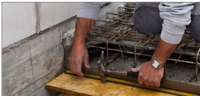
Abb. 87: Untere Nagelleiste anbringen, Abstand von \geq 40 \text{ mm} zur Tronsole® Typ T einhalten
