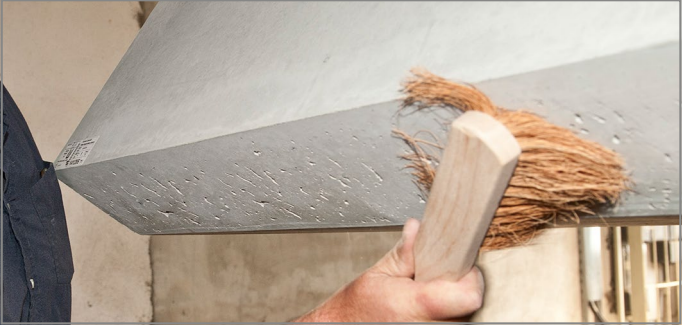
Abb. 108: Staub und lose Teile entfernen
