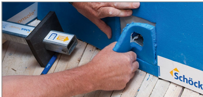
Abb. 65: Ausschnitt für die Brandschutzmanschette entfernen
