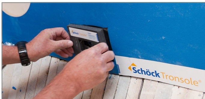
Abb. 66: Brandschutzmanschette einsetzen
