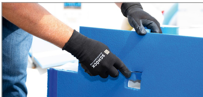
Abb. 34: Geometrie der Podesthülse ausschneiden
