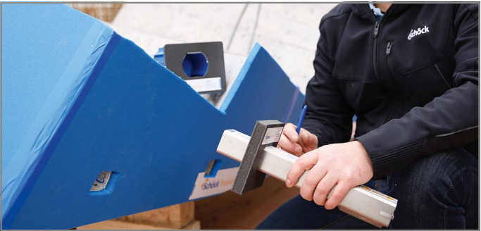
Abb. 73: Tragelement bei Laufhülse positionieren
