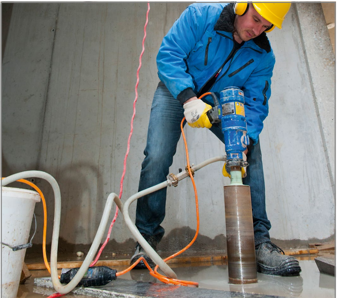
Abb. 114: Kernbohrung mit 100 mm Durchmesser in Bodenplatte setzen
