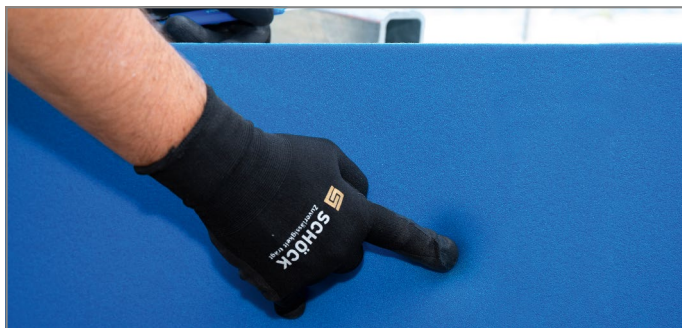
Abb. 33: Aussparung der Podesthülse ertasten
