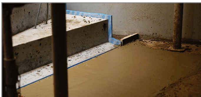
Abb. 98: Anschlussbereich betoniert
