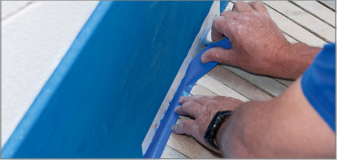
Abb. 68: Zur Vermeidung von Schallbrücken ist die Tronsole® Typ Q und Typ L gegen Betonschlämme abzukleben
