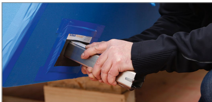
Abb. 77: Tragelement montieren
