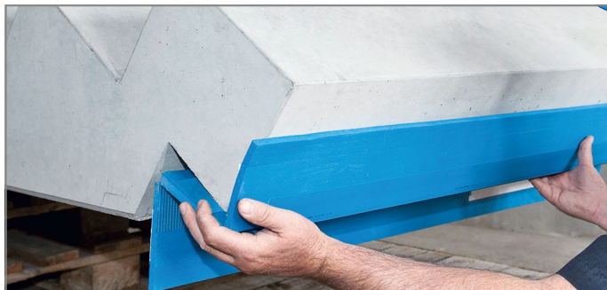
Abb. 105: Obere Schenkel von Tronsole® Typ F ankleben
