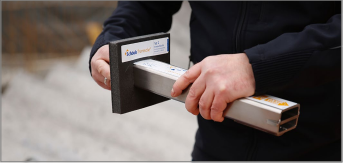
Abb. 72: Bei Brandschutzanforderung R 90 Brandschutzmanschette auf Tragelement aufstecken
