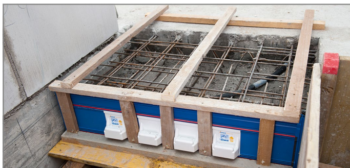
Abb. 93: Vor dem Betonieren
