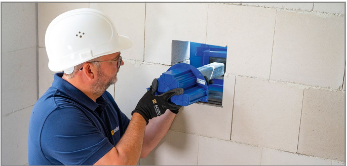
Abb. 43: Tragelement und Wandelement in Podesthülse einfahren
