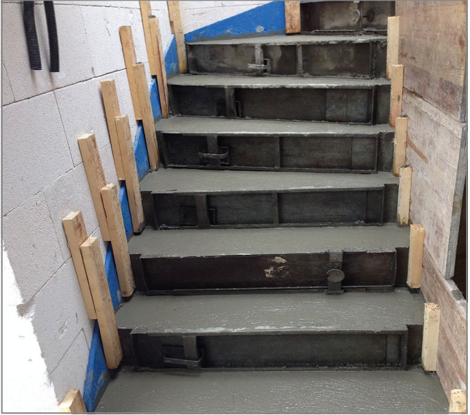
Abb. 131: Treppenlauf betonieren
