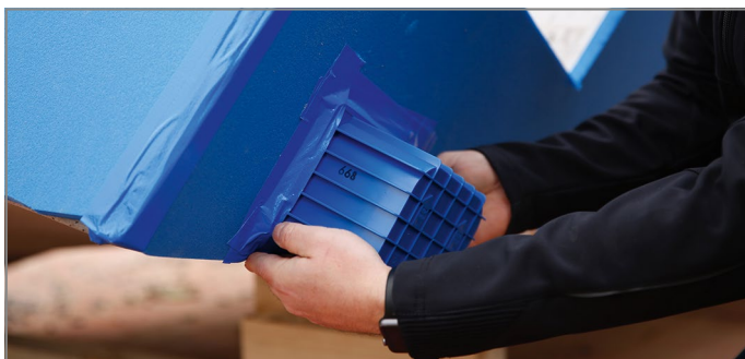
Abb. 80: Wandelement für Einbauzustand waagrecht ausrichten und abkleben
