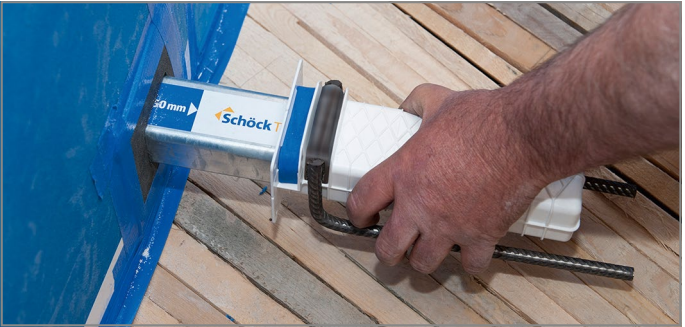
Abb. 69: Laufhülse aufstecken
