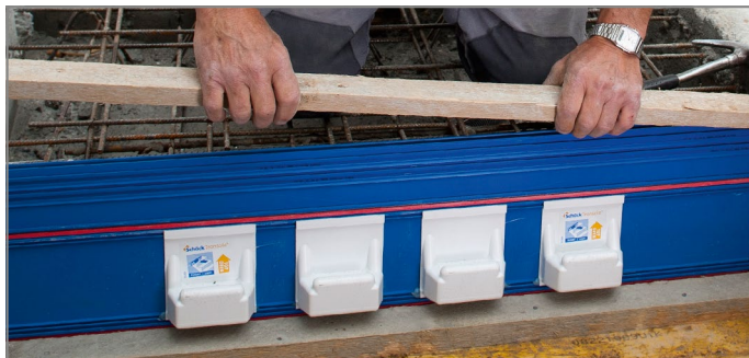
Abb. 91: Obere Nagelleiste in Tronsole® Typ T einklipsen
