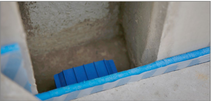
Abb. 85: Aussparung vergießen
