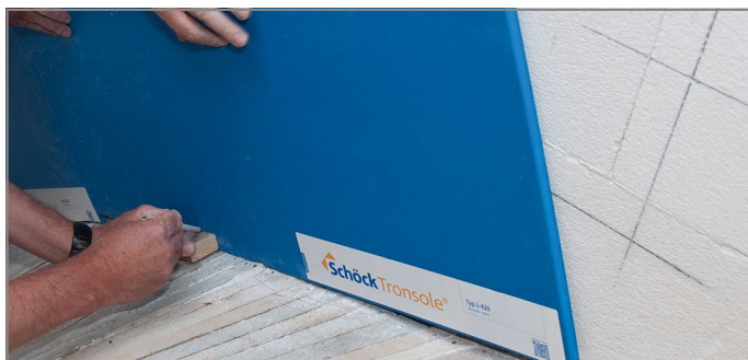
Abb. 124: Unteres Laufprofil von Tronsole® Typ L anzeichnen
