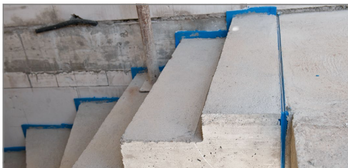
Abb. 134: Gerade Fugenausbildung am Treppenaustritt
