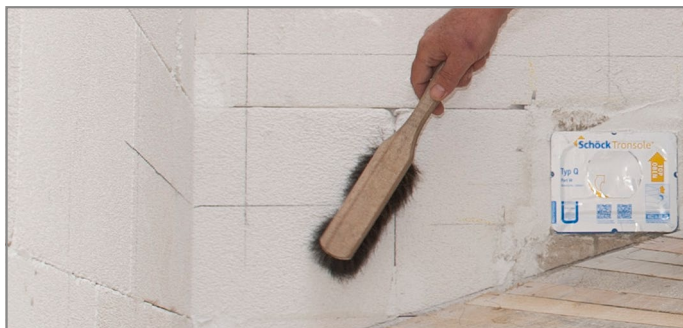
Abb. 123: Staub und lose Teile entfernen
