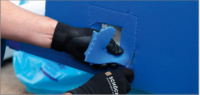
Abb. 36: Geometrie der Podesthülse ausschneiden
