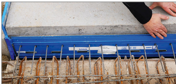
Abb. 96: Treppe einsetzen und stützen
