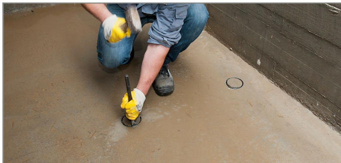
Abb. 115: Kernbohrung ausbrechen
