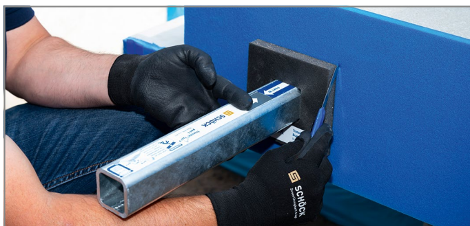
Abb. 35: Brandschutzmanschette und Tragelement positionieren, Geometrie der Brandschutzmanschette auf Fugenplatte Typ L einritzen
