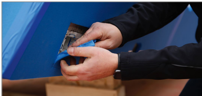
Abb. 75: Ausschnitt für die Brandschutzmanschette entfernen
