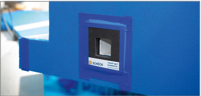
Abb. 37: Brandschutzmanschette einsetzen und abkleben
