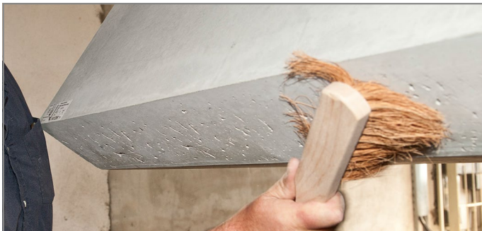
Abb. 102: Staub und lose Teile entfernen
