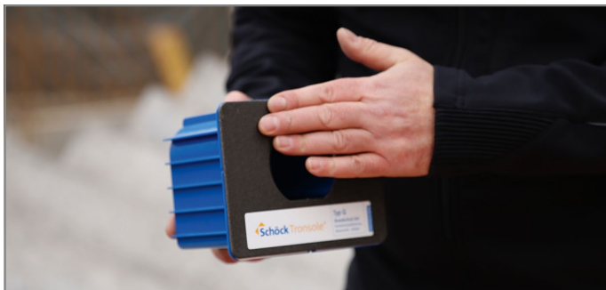
Abb. 78: Brandschutzabdeckung auf Wandelement aufkleben
