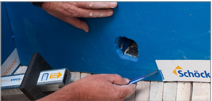
Abb. 64: Geometrie der Brandschutzmanschette ausschneiden
