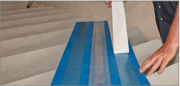
Abb. 109: Schutzfolie von Tronsole® Typ B abziehen
