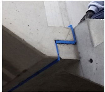
Abb. 3: Blaue Linie zeigt durchgängige Entkopplung
