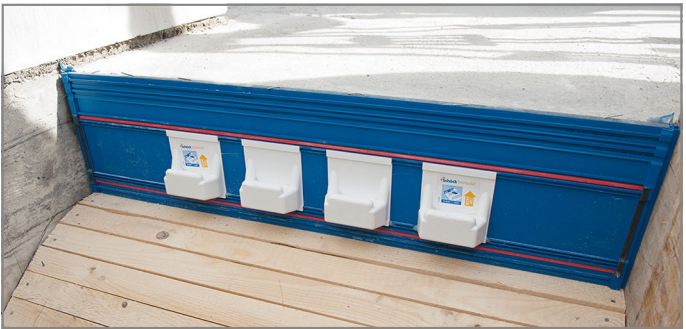
Abb. 95: Oberer Anschluss mit Tronsole® Typ T
