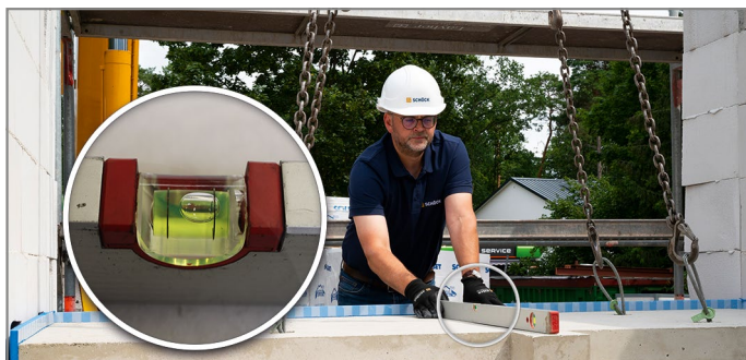
Abb. 46: Einfederung gemäß Technischer Information berücksichtigen
