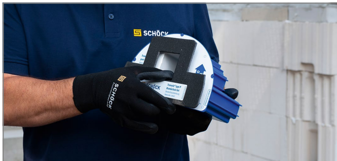
Abb. 41: Brandschutzabdeckung am Wandelement aufkleben
