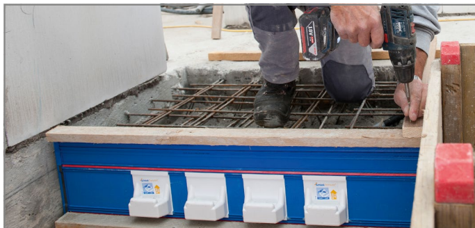
Abb. 92: Tronsole® Typ T abstützen
