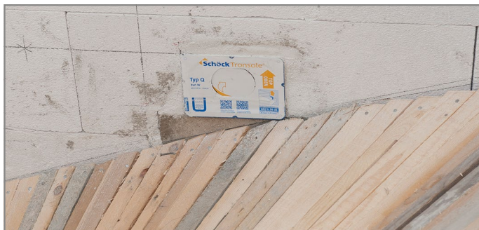
Abb. 59: Wandelement Tronsole® Typ Q in KS-Wand eingemauert
