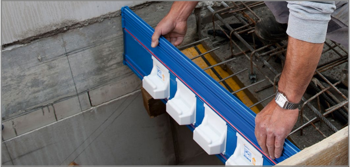
Abb. 88: Tronsole® Typ T einsetzen
