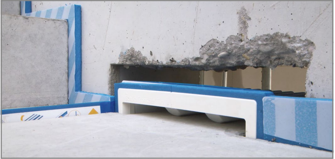
Abb. 57: Wandaussparung vergießen
