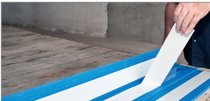
Abb. 104: Schutzfolie von Tronsole® Typ F abziehen
