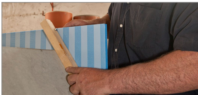
Abb. 140: Schöck Tronsole® L mit Überstand (ca. 30 mm) abschneiden
