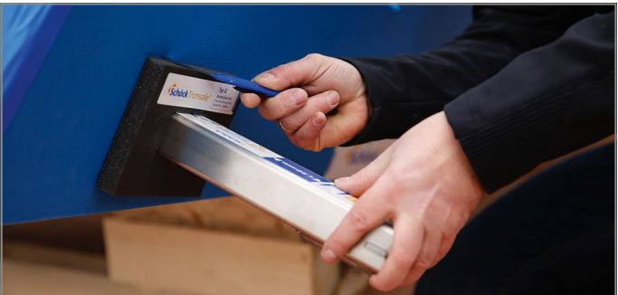
Abb. 74: Geometrie der Brandschutzmanschette ausschneiden
