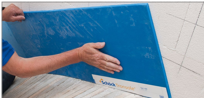
Abb. 129: Tronsole® Typ L aufkleben
