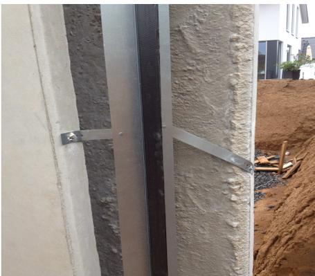
Uni-Sollrißelement im Bereich der Hohlwandelemente als Stoßfugenelement oder ECKelement für Wandbreiten von 240-300 mm .
