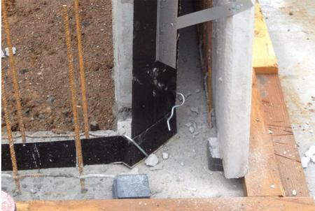
Detail Bodenplatte Wand mit Siegraflex 45° ECKelement im Boden und aufgehendem Siegraflex-Sollrißelement.
