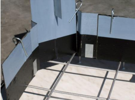
Detail Bodenplatte Wand mit Siegraflex 45° Eckelement im Boden und aufgehendem Uni-Sollribelement.
