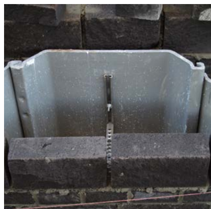
Anschluss von Verblendmauerwerk an Spundwand
