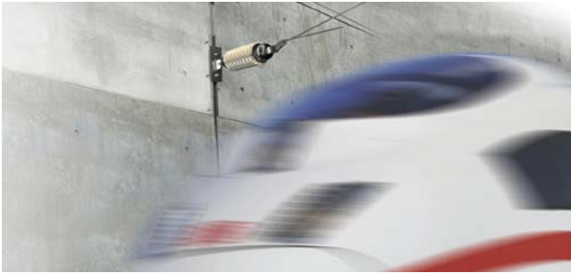
Oberleitung im Tunnel
