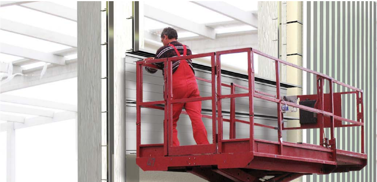
Montage einer mehrlagigen isolierten Trapezblech-Wand.
