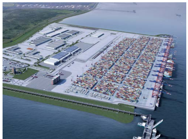
JadeWeserPort Wilhelmshaven, Deutschland
