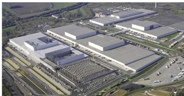
Befestigung auf dem Dach
