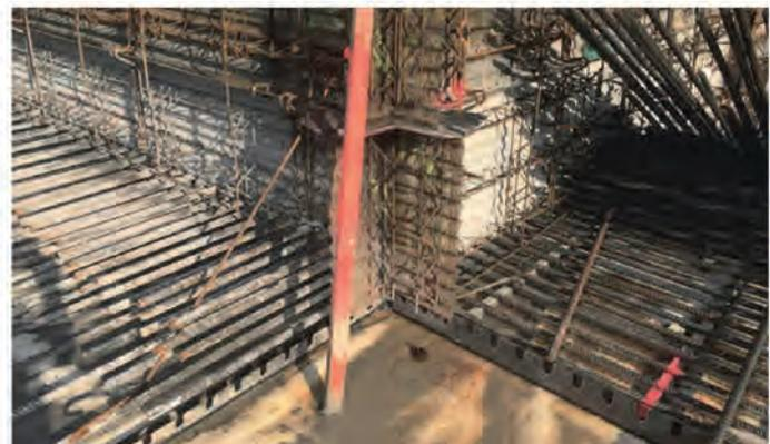
TRiGOFORM® Abschalssystem perfect 34117 („Verzahnte Fuge“ nach DIN EN 1992-1-1/NA-2013-04 mit Fugenblech 300/2 mm, patentiertes Rückverankerungssystem „perfekt“, safeform Abdichtungseiste in Vollblech. Der Einbau des TRiGOFORM® Abschalssystems erfolgte auf Frischbetonverbundfolie.
