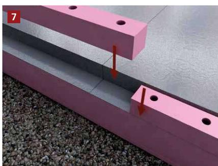
Das Absatzprofil wird stoßversetzt und außen bündig wieder auf den Systemschenkel aufgeschraubt.
