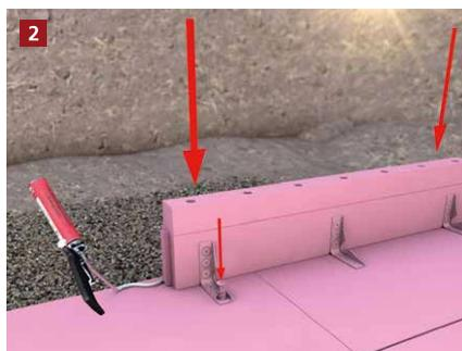
Der Pistolenschaum wird aufgetragen, die Schenkel werden in den Schaum gedrückt und verschraubt.
