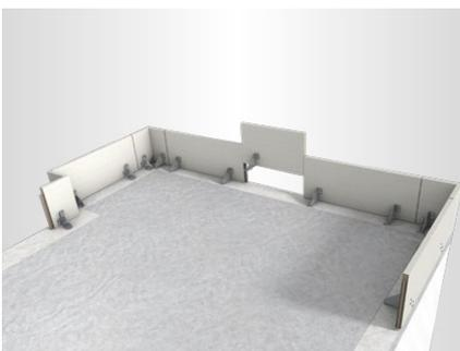
Das letzte Element wird bauseits in der Länge angepasst und zwischen die bereits verbauten Elemente gesetzt.
